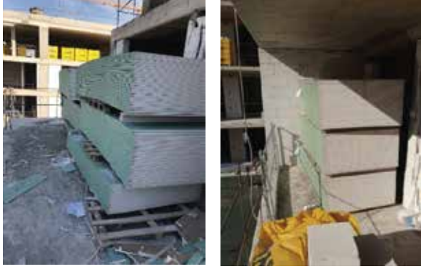
Şekil 5 : Alçı Levhaların Depolama Alanlarından İmalat Katlarına Aktarılması
