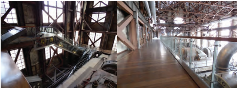
Şekil 3.Yeniden işlevlendirme sonrası eklenen yürüyen merdiven ve gezi iskelesi
