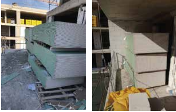
Şekil 5 : Alçı Levhaların Depolama Alanlarından İmalat Katlarına Aktarılması
