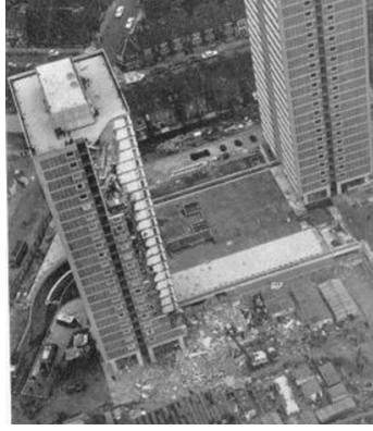
Şekil 1. Ronan Point apartmanından bir görünüş [1]
