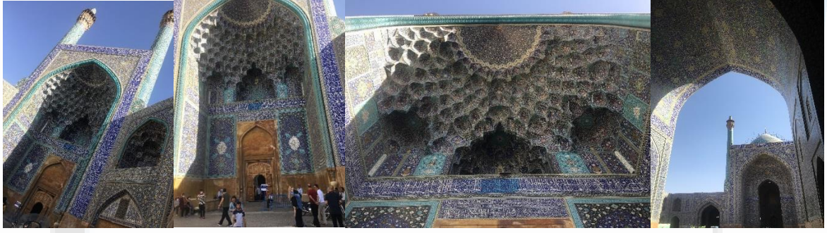
Şekil 6. Mescid-i Şah camii taç kapısı ve avluya geçiş
