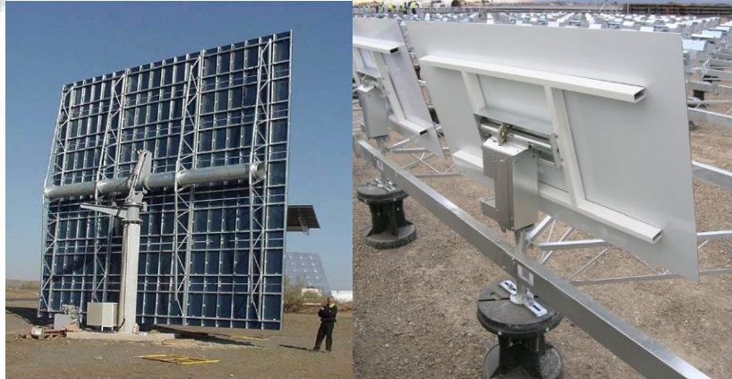
Şekil 3. Heliostat ve Kaide (PSA) (Tellez vd.,2014:18-19)
